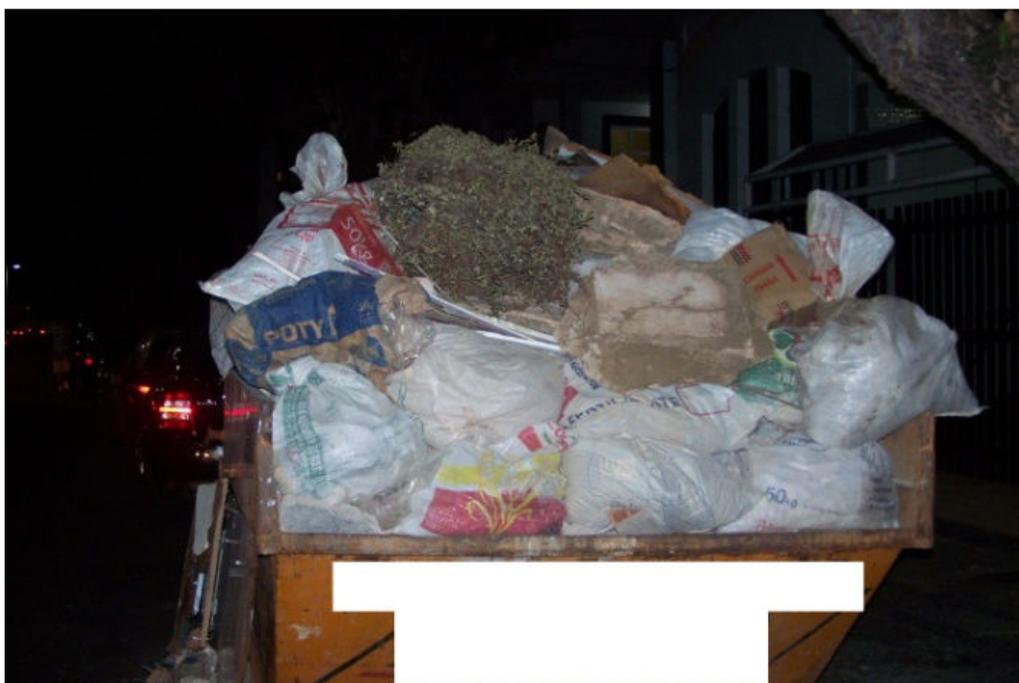
**Figura 77: Caçamba Estacionária em via pública com resíduo distintos a classe A do RCD. acondicionamento inadequado.**
