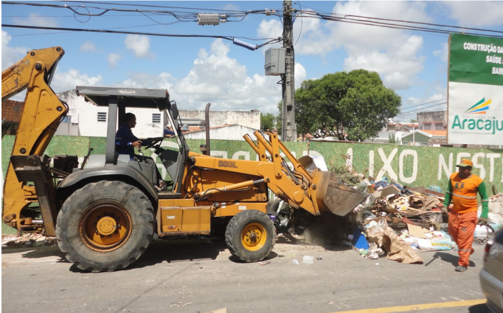
Figura 19: Remoção de resíduos acumulados – Aracaju/SE
