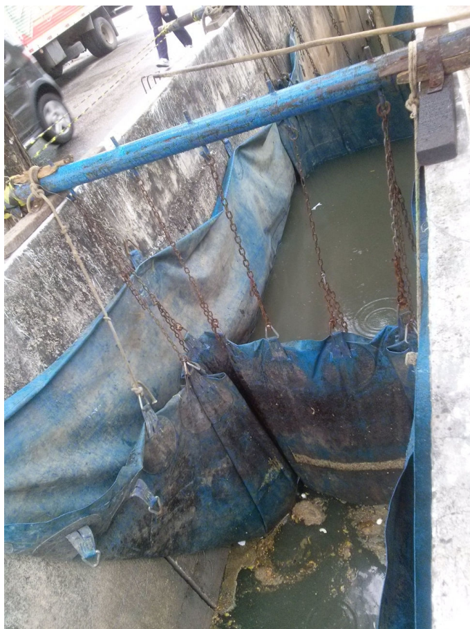
Figura 24: RSPSB – Limpeza de canal pelo método “barragem móvel” – Aracaju/SE
