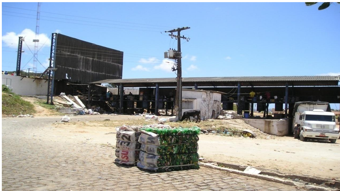
Figura 11: Área de triagem de uma estação de transbordo, em Natal - Rio Grande do Norte, 2006.
